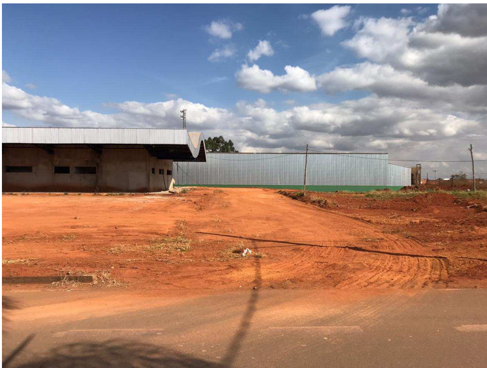
Foto 2 – Corredor de saída dos ônibus
