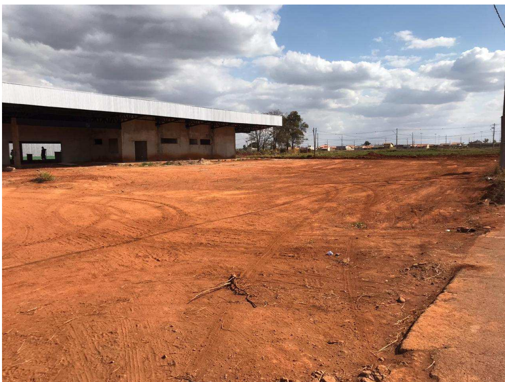
Foto 4 – Vista lateral esquerda do estacionamento
